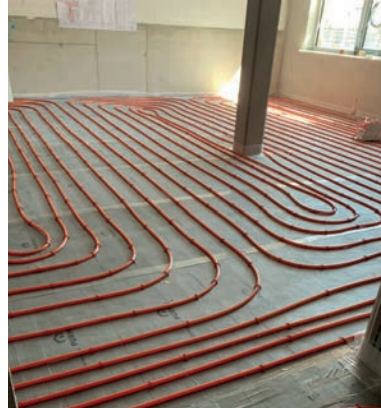
Fußbodenheizung fertig verlegt
