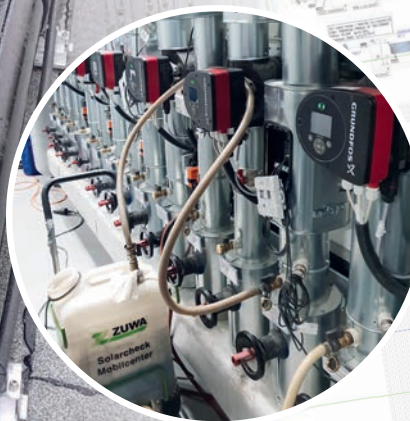
Verteiler Klimatisierung
