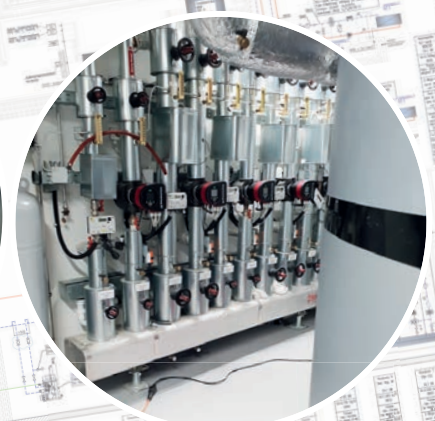
Verteiler Heizung
