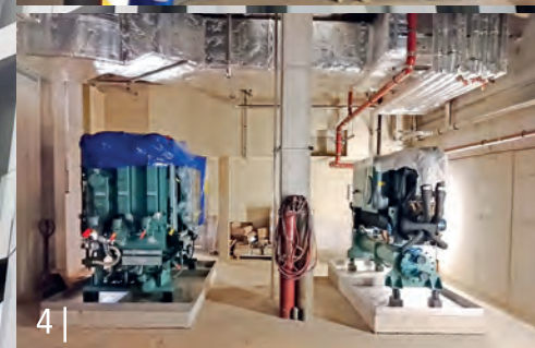
1 | Der Rückkühler auf dem Dach 2 | – 4 | Montage des Kaltwassersatzes
