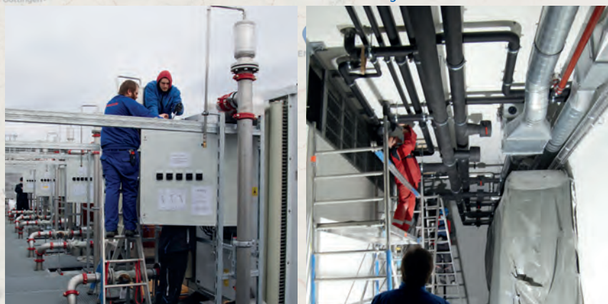
Zwei Mitarbeiter schliessen die Rückkühler an
