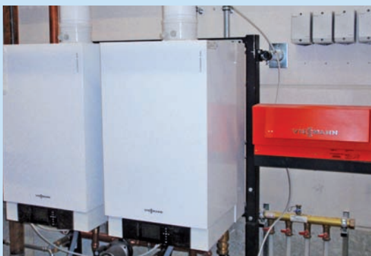
Brennwert Kesselkaskade
