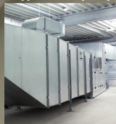
Lüftungsgerät mit Wärmerückgewinnung
