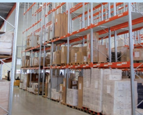
Hochregallager mit Industriebodenheizung
